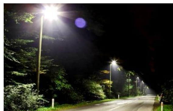
Luminaire sur mât 371
